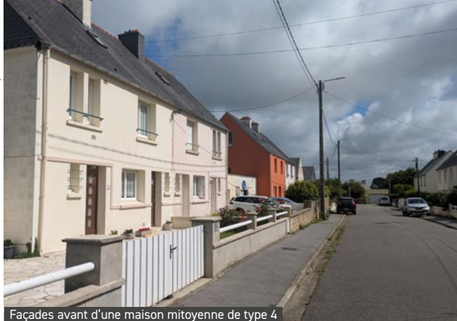
Façades avant d'une maison mitoyenne de type 4 du lotissement de Kerallan.
