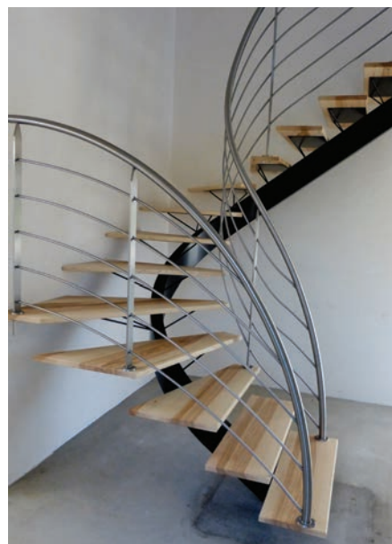
Exemple de réalisation : un escalier avec limon en acier thermolaqué noir tube rectangulaire, marches en frêne et garde-corps en inox brossé avec main-courante cintrée. Le résultat de 70 heures de travail !
