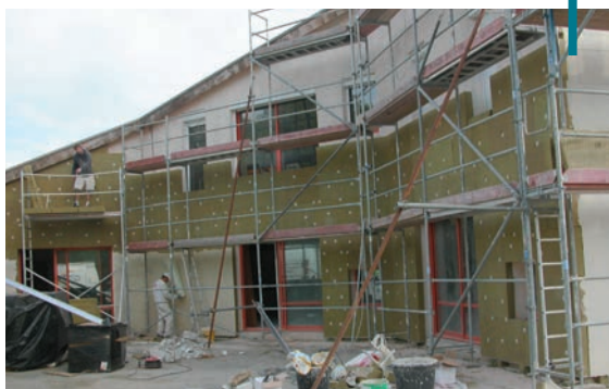
Isolation par l'extérieur de l'Espace Tabarly.
