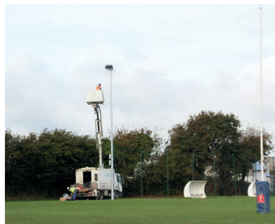
L'éclairage du terrain C en cours de déploiement à Kéramazé
