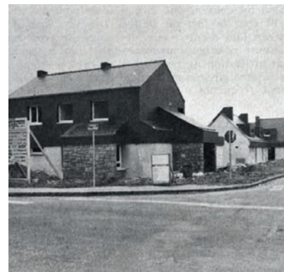
Construction de la gendarmerie en 1983.
