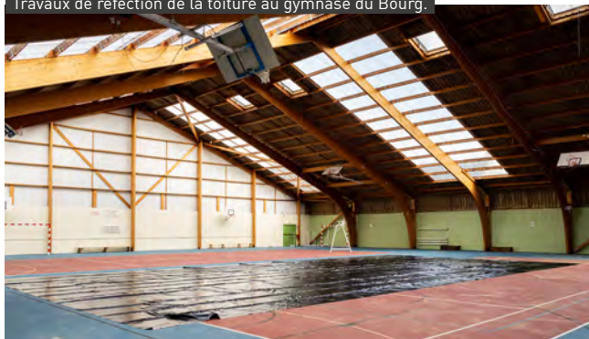
Travaux de réfection de la toiture au gymnase du Bourg.
