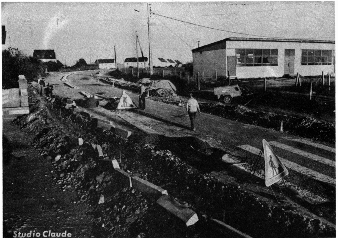
Chantier de la rue de Kérallan
