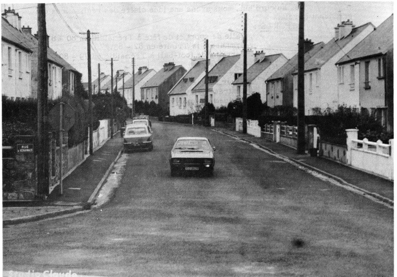
Finition des trottoirs du quartier de Kéramazé
