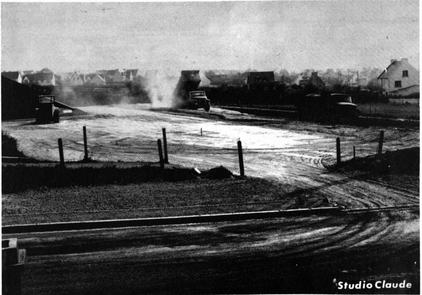
Travaux sur le plateau de la salle polyvalente
