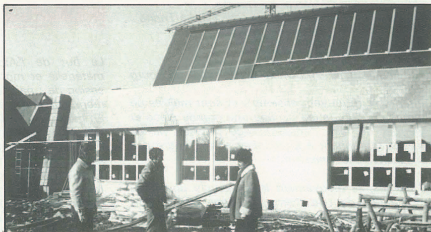
Madame DUVAL Notre Conseillère générale, s'intéresse aux travaux : Du Centre Social de La Trinité
