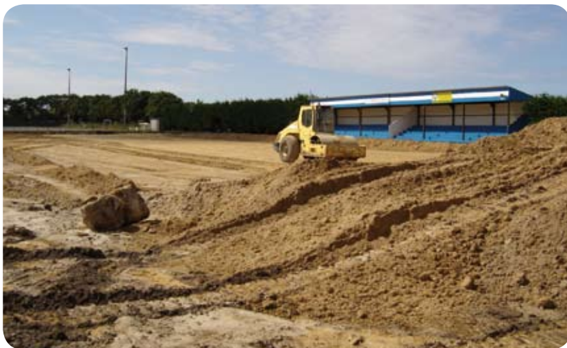
Travaux de terrassement.
